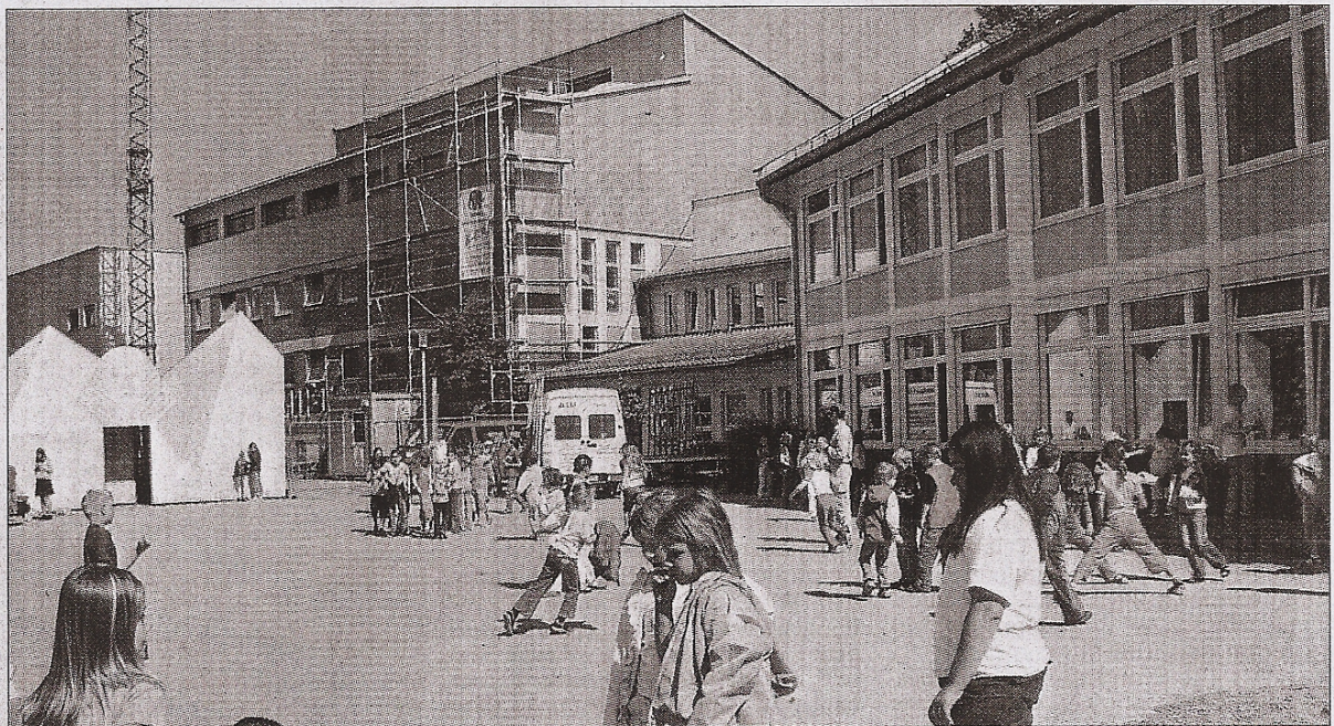
Der Erdaushub für die Fundamentierungsarbeiten ist beendet. Jetzt kann an der Hauptschule die Rettungstreppe montiert werden. Sie wird der stählernen Treppe an der Grundschule gleichen. Fotos: Ebner
